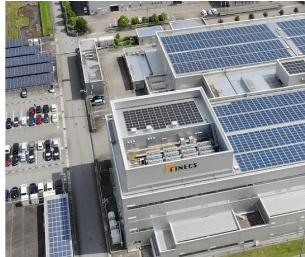
■下図のように同設備導入により上条工場の自家消費率が 0%→2.3%に向上
